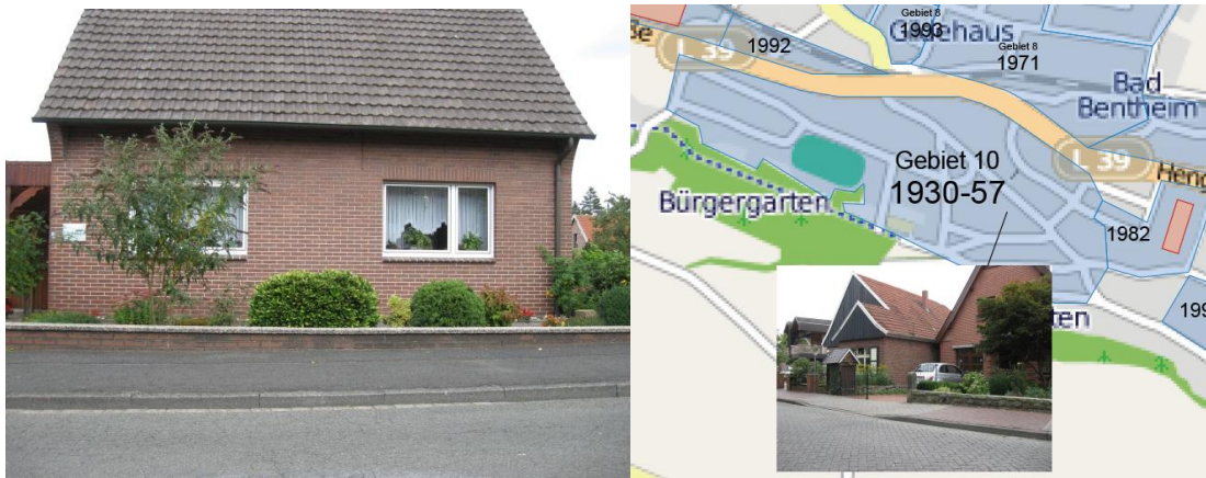
Bild 23: typisches Einfamilienhaus im Untersuchungsgebiet 10
